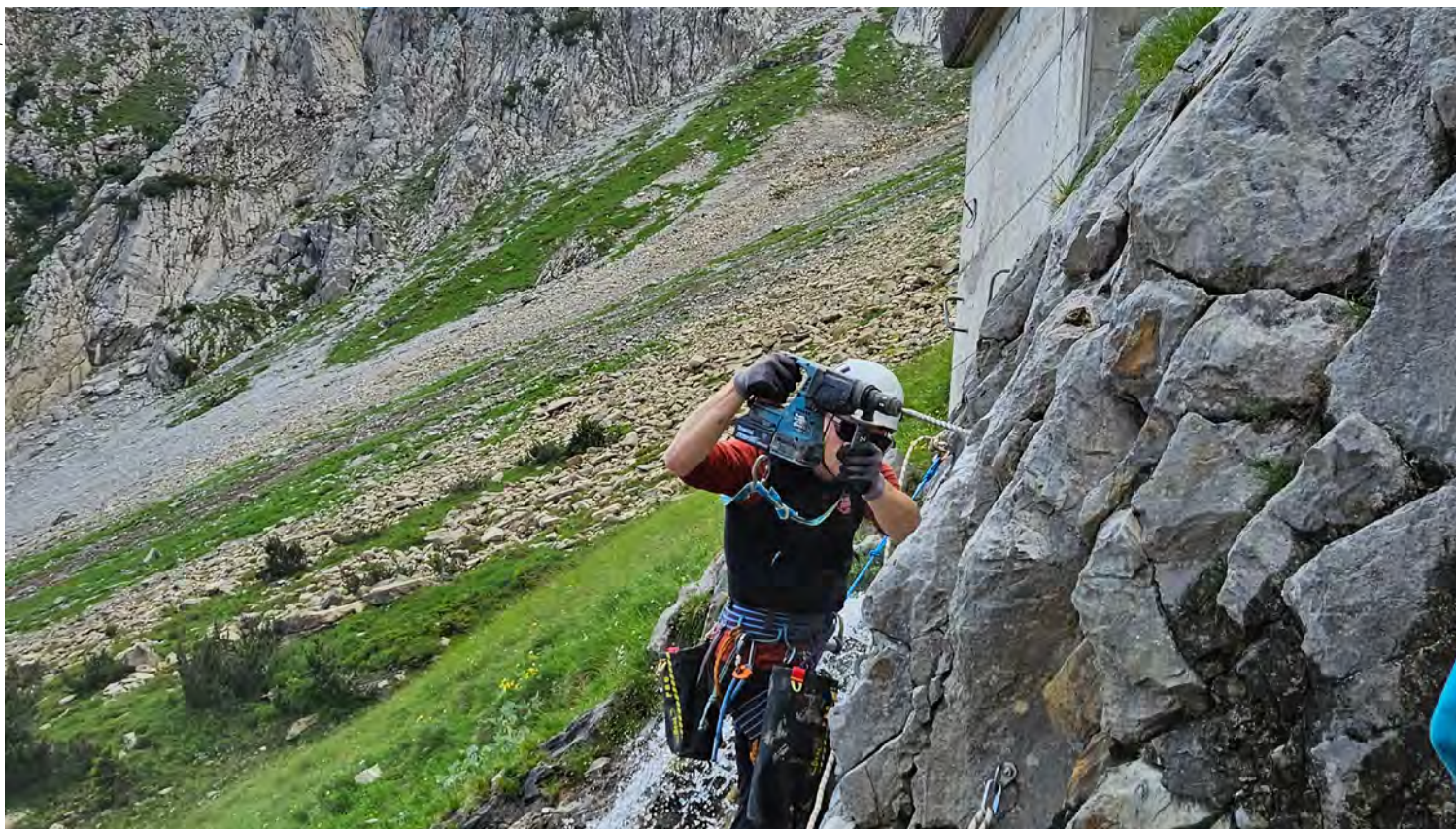
Sanierung Kraftwerksweg: Nun kann unser Hüttenteam sicher zum Kraftwerk absteigen.
